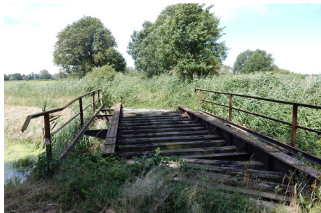
De constructie van de brug
